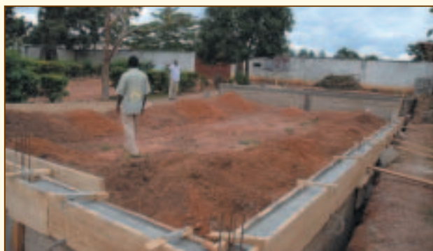
Costruzione dei laboratori
