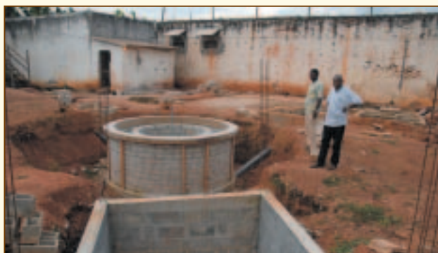
Installazione del biodigestore
