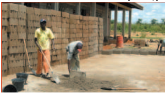
La scuola in via di costruzione al Collège Van Heygen
